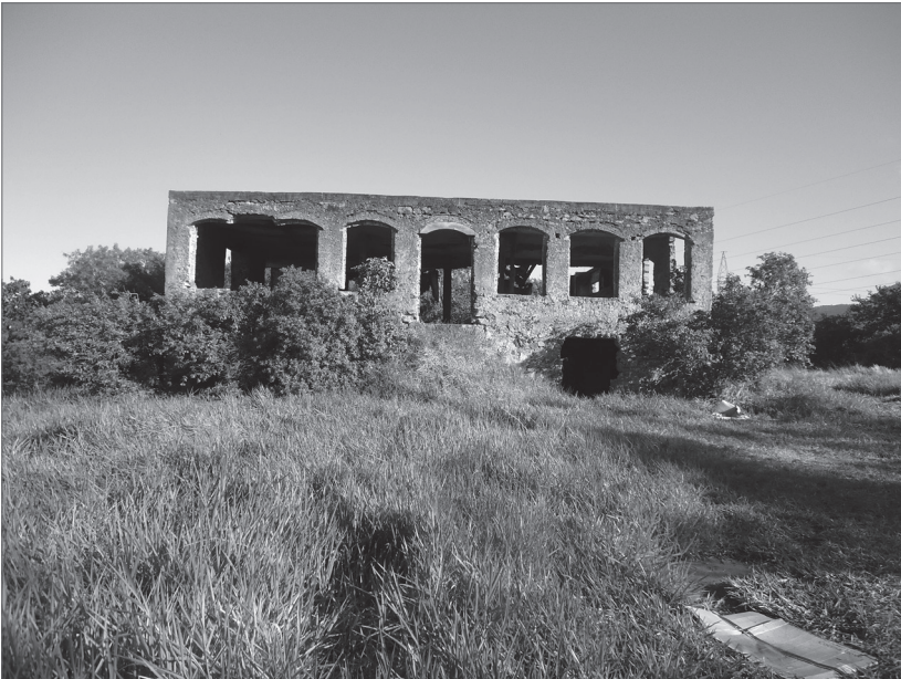
Casa da sede da Fazenda da Freguesia de Carapina, doada por Vasco Fernandes Coutinho, no ano de 1577, a Vicente Vaz. Construção tombada pelo Conselho Municipal de Cultura da Serra – ES. Avançado estado de degradação. Datada de meados do século XVI. Acervo do autor. Data de 23 de julho de 2013.
