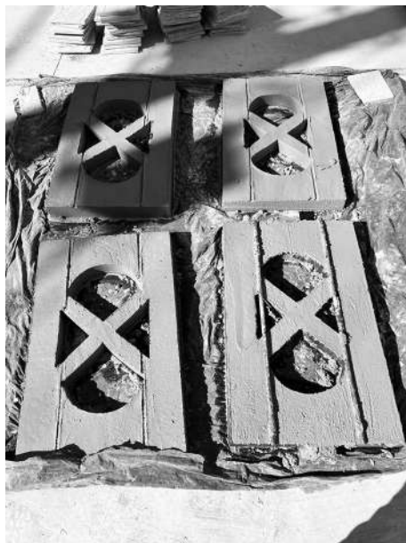
Figura 22 – Detalhe reprodução das peças do guarda-corpo do Viaduto Caramuru, Fonte – SEDEC/GPU/CRU, jun. 2020.
