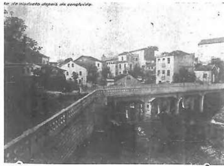
Aspecto do viaduto de São Francisco, em Vitória
