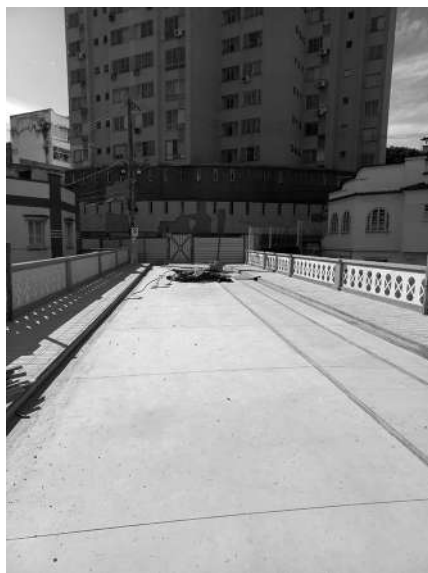
Figura 15 – pista do Viaduto Caramuru em restauro, mostrando os trilhos.
