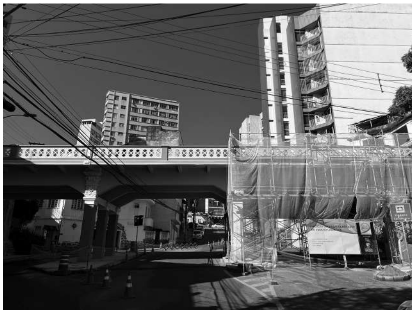
Figura 20 – Viaduto Caramuru em restauro, visto da Rua Caramuru. Fonte – SEDEC/GPU/CRU, ago. 2023.
