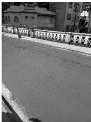
Figura 18 – Viaduto Caramuru em restauração, e seu entorno residencial Fonte – SEDEC/GPU/CRU, jun. 2023.
