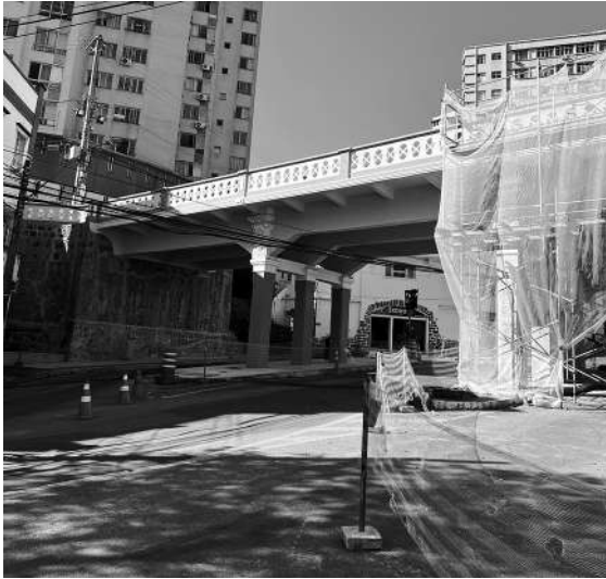
Figura 1 – Viaduto Caramuru em restauro. Vitória. ES. Fonte – SEDEC/GPU/CRU, ago. 2023.
